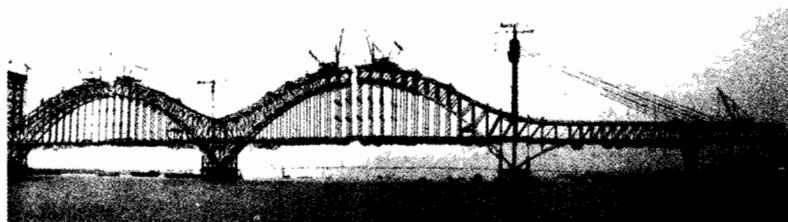
说明图 14.3.10 钢桁拱桥主跨钢梁合龙前状态
